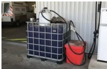
Cuve et pompes
